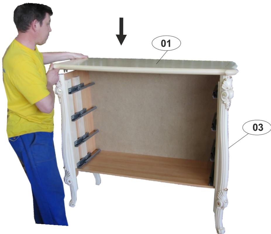
Зафиксировать при помощи эксцентриковой стяжки и установить заглушки.
